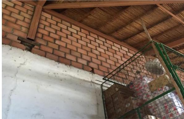
Ahí están en reparación los techos como van a quedar, con madera se sostiene la madera, ahí está lo que es la caña brava obligatoriamente tiene la teja de zinc y encima va la teja de barro, para que cuando pase un animal un aire, no vayan a levantar eso, las bodegas como quedaron.
